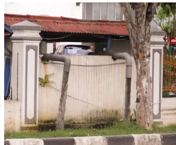
La gare de Semarang donne lieu à pompage permanent des eaux
