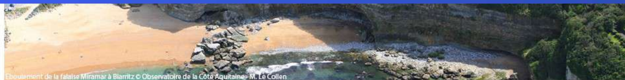
Eboulement de la falaise Miramar à Biarritz © Observatoire de la Côte Aquitaine - M. Le Collen
